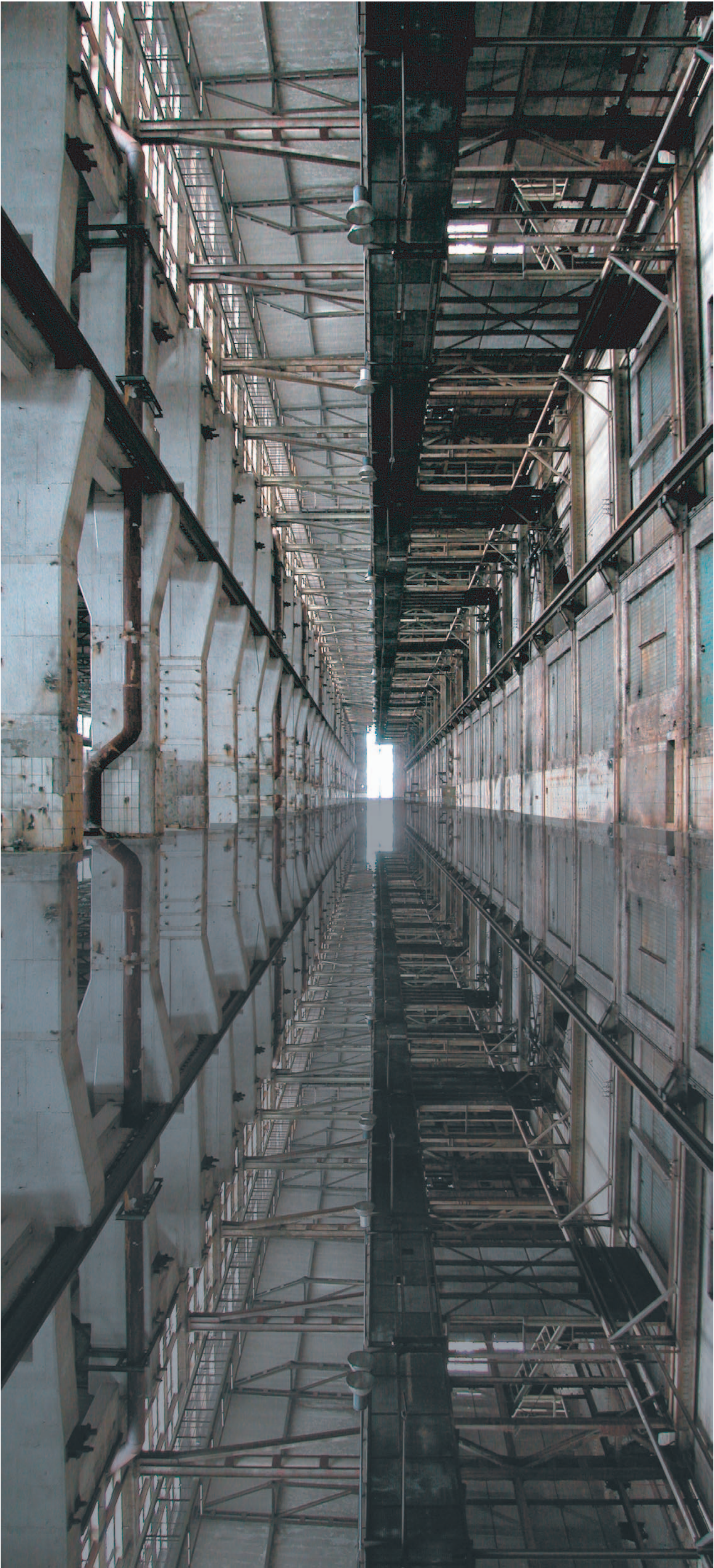
Man betritt die obere Ebene der Hilfsmaschinenhalle, die mit ihrem ruhigen Wasserspiegel mentale Unterstützung für den letzten Schritt gewährt.
