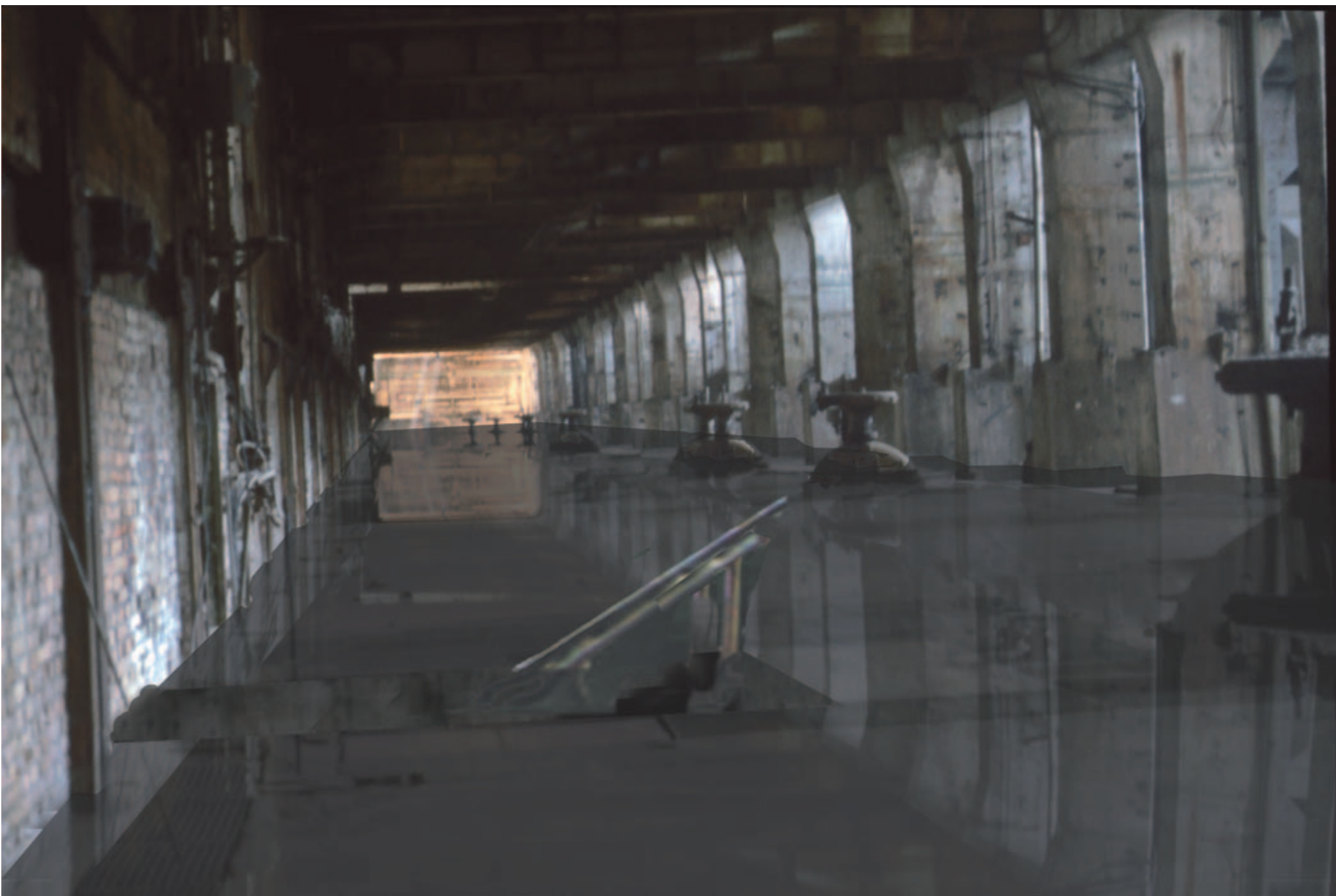
kryptischen Kritzeleien in den Stahlgebilden weisen auf eine versunkene Tür im Nordteil der Halle
