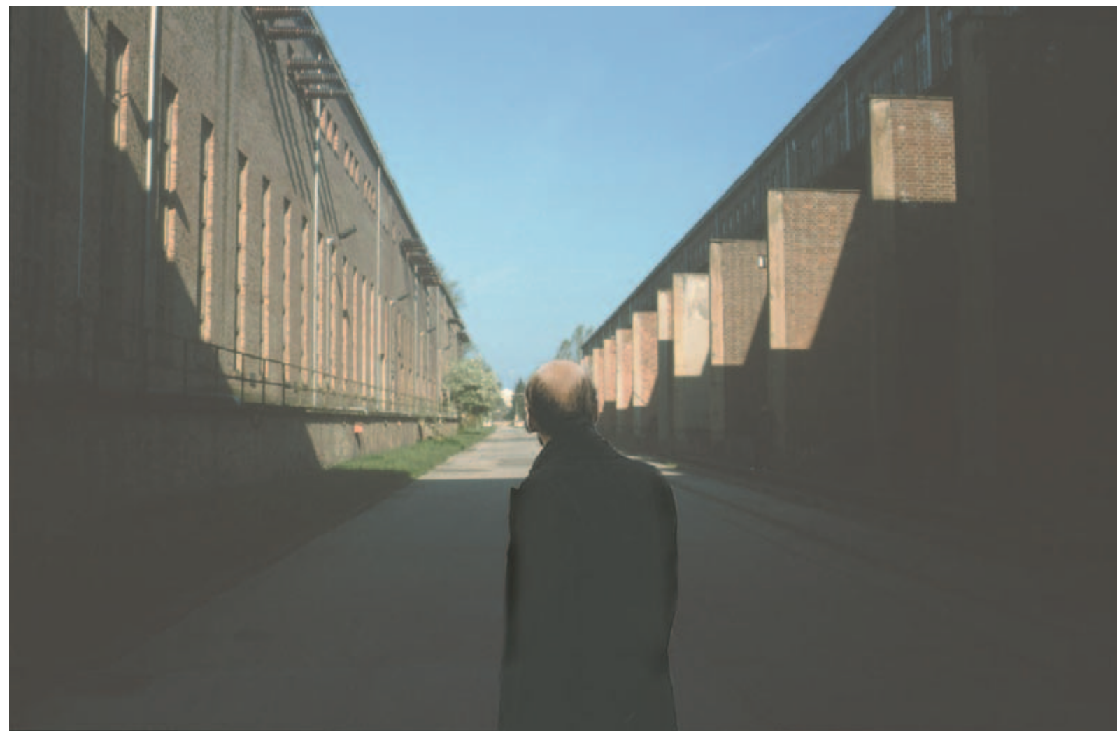
am Kraftwerk: erfolglose Suche nach dem Eingang, Rückzug
