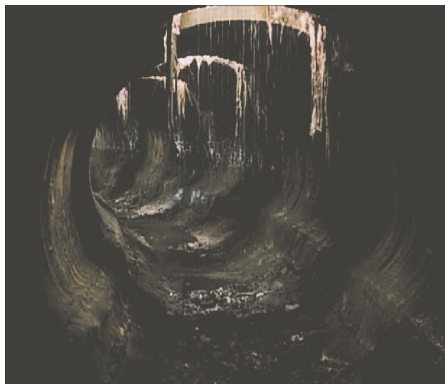
durch 1,70 m durchmessende Rohre gelangt man unter die Maschinenhalle
